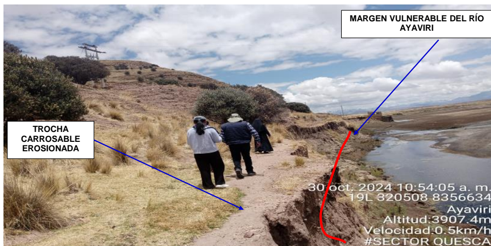
FIGURA N°02: VIVIENDAS Y POSTES DE ALTA TENCION PROPENSAS A LA EROSION EN LA MARGEN DERECHA EN EL SECTOR DE QUESCA, ASI MISMO LA EROSION TOTAL DE LA VIA CARROSABLE, PRODUCTO DE LA EROSION.
